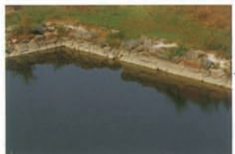
depósitos industriales industrial water tanks
